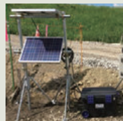
ソーラー電源ユニット
