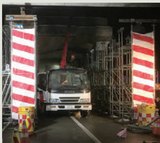
設置例 トンネル両側から型枠支保工施工エリア侵入時の高さ超過を警戒
