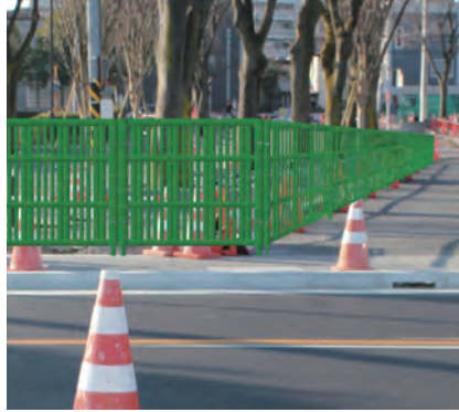
竹プラフェンスの設置例
