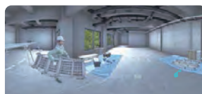
⑧ 可搬式作業台転落災害
