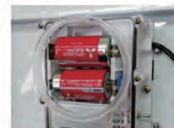
防雨型の電池ケース。雨の侵入を防ぎます。
