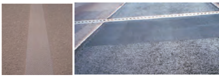
ジョイント部の段差修正
